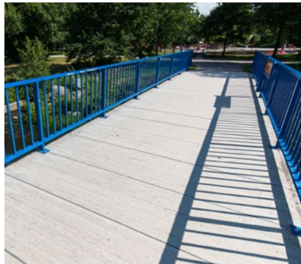
Mätäojan silta, Vantaa
