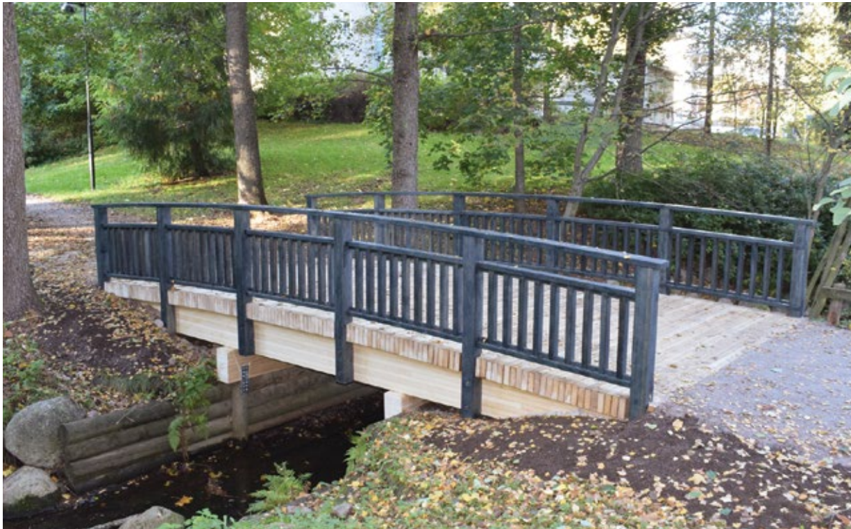
Helsingin kaupungin rakennusvirasto Stara purki istukkakäävän aiheuttamista lahovaurioista kärsineen Vesalan Aarre-puiston sillan. Tilalle rakennettiin kuvassa oleva Accoya -puinen silta, joka kestää maan- vastaisissa rakenteissa ilman pintakäsittelyäkin vähintään 25 vuotta.
