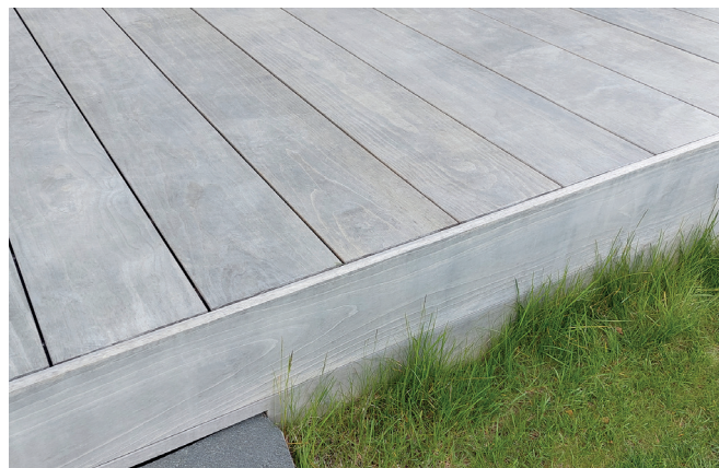
2 vuotta harmaantunut Accoya-terassi
